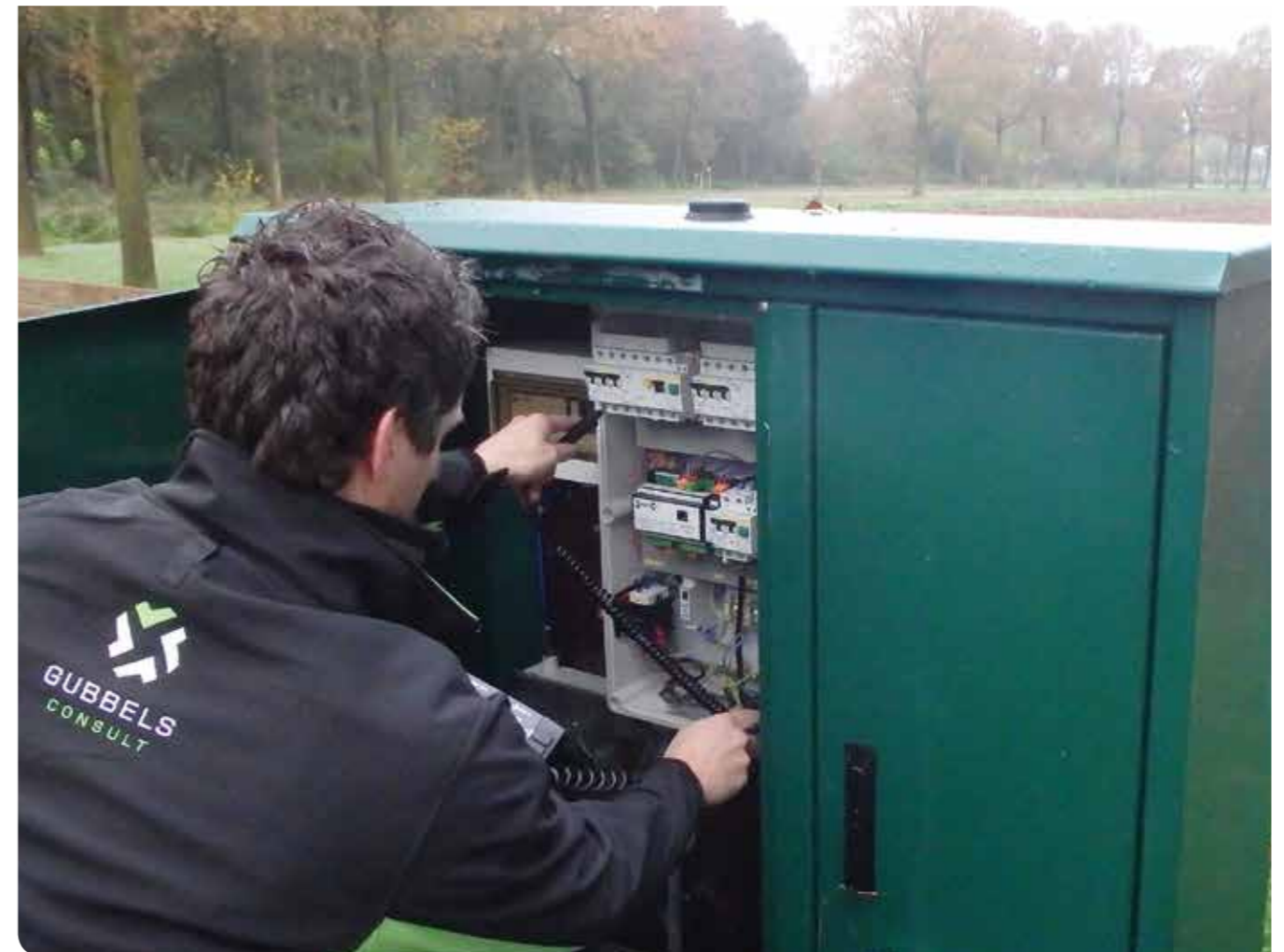
Roy Gubbels is namens iKeur lid van de NTA 8220-werkgroep bij NEN en Level III gecertificeerd thermografie-trainer bij IRIS Thermovision. Daarnaast heeft hij zijn eigen inspectie- en adviesbureau Gubbels Consult.
